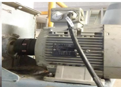
Gambar 3.4 Kopling setelah modifikasi
