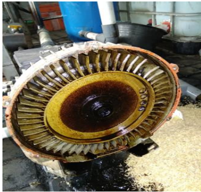
Gambar 5. Kondisi Blower Hisap setelah dilakukan cleaning
