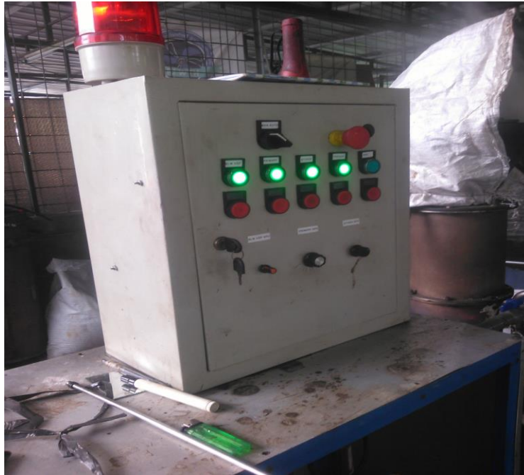
Gambar.4 penerapan SOP yang benar dalam menggunakan control panel
