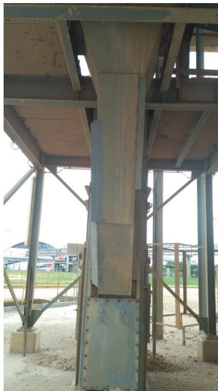
Gambar.1 Kondisi Outlet Chute 361-CV1
