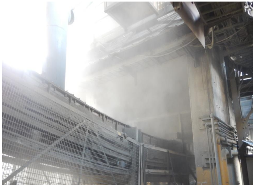
Gambar 1. Kondisi Berdebu di Area Cooler
