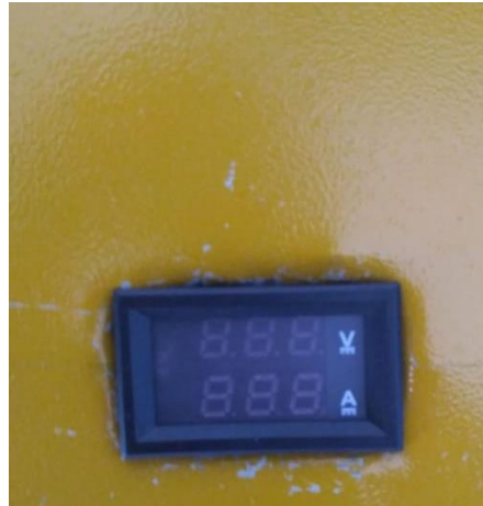
Gambar. 4. Volt-meter dan Ampere-meter
