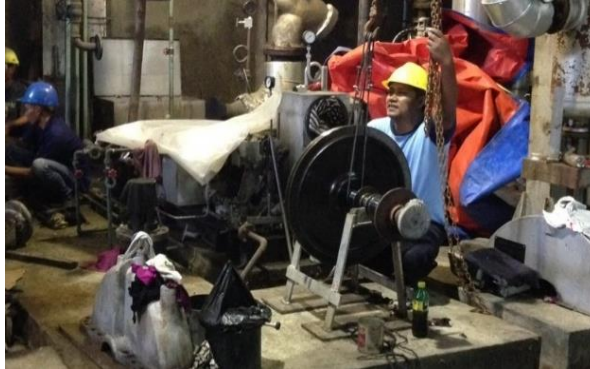
Gambar 3.6 Pemeriksaan ( Overhaul ) Rotor Turbin
