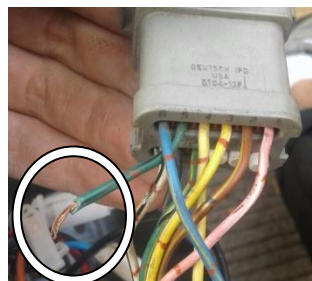
Gambar 4. Pemeriksaan Air Restriction Indicator
