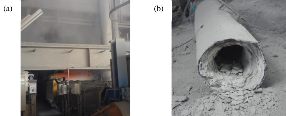
Gambar : 3.(a) kondisi berdebu pada belt conveyor 531-BC3 3.(b) kondisi dedusting duct dari dust collection system pada belt conveyor 531-BC3
