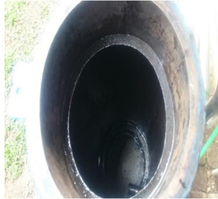
Gambar 6. Kondisi Filter setelah dilakukan cleaning
