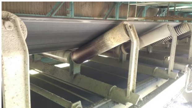
Gambar 1 Lokasi Pemasangan Belt Weigher .
