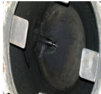
Gambar 8. Kondisi Reaktor setelah dilakukan cleaning
