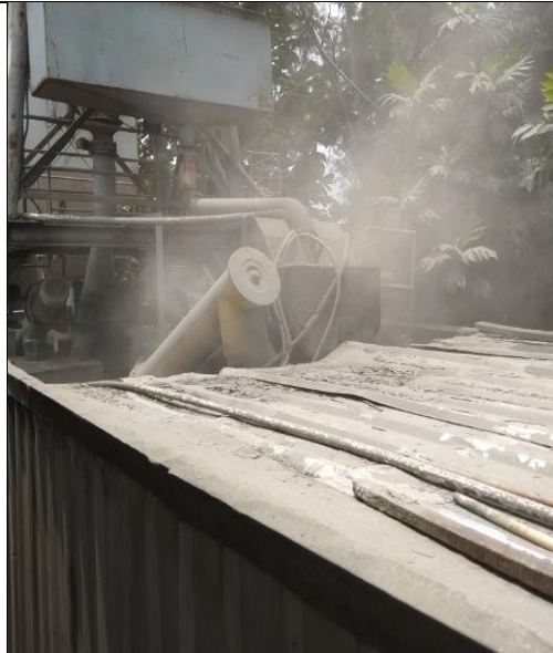
Gambar 2. Kondisi berdebu di sekitar loading point
